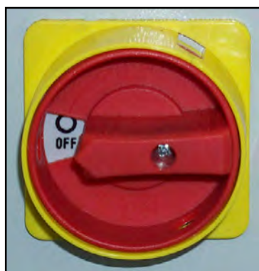
F) Interruttore generale caldaia
